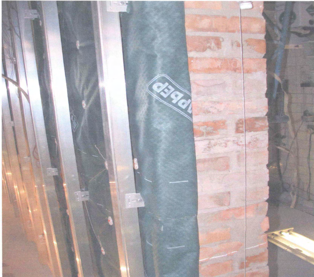
Рис.1.2 - Встановлення елементів утеплення несучої частини стін
