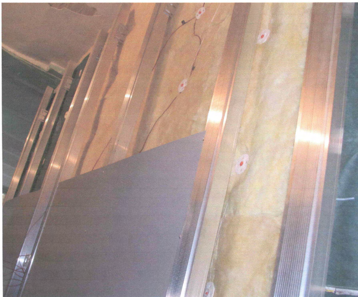
Рис.1.6 – Зовнішній вигляд дослідних конструкцій з утеплювачем із плит із скляної вати з повітрогідрозахисним мембранним шаром (зразок № 4) та без мембранного шару (зразок №3) під час монтажу захисного зовнішнього шару.
